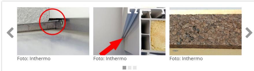
Die dauerhafte Funktion von Holzkonstruktionen wird von der Dichtheit des Fensteranschlusses maßgeblich beeinflusst. Feuchteintritt muss unbedingt verhindert werden. Schwachstellen wie das „Gewerke Loch“ werden in den gängigen Richtlinien bisher nicht ausreichend behandelt oder als Problem erkannt.
